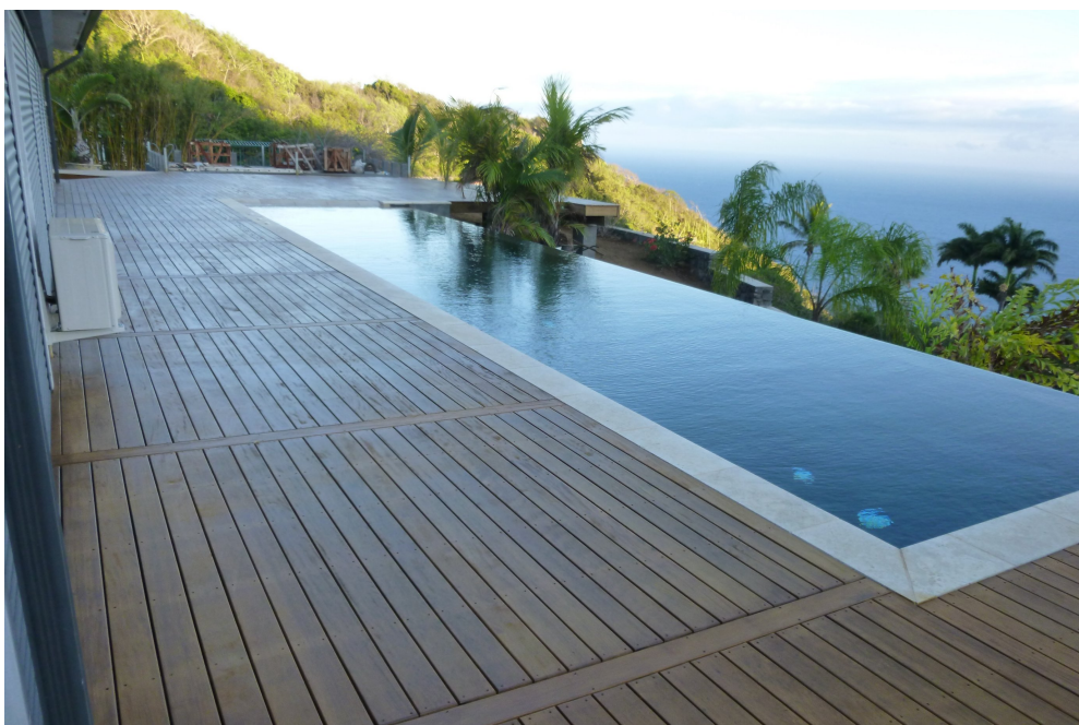
Terrasse bordant une piscine à débordement (fabrication : Agencement Tiby - fourniture : Fibres Industries Bois) La Réunion (France)
